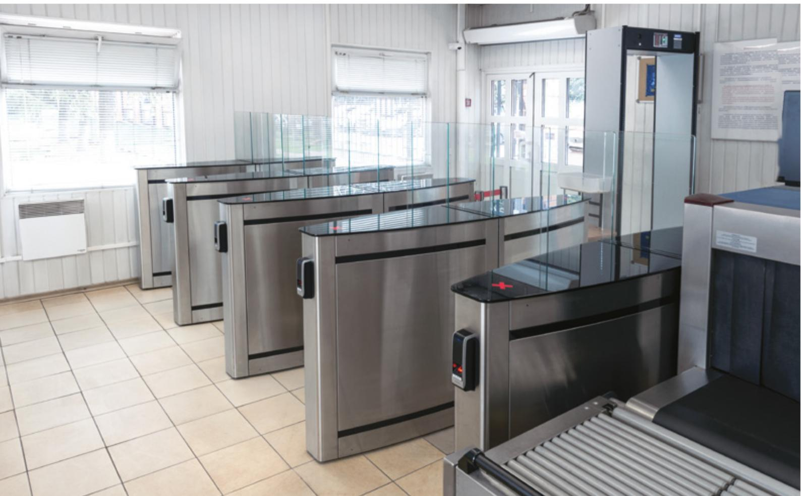
Анализ нахождения людей в контролируемой зоне осуществляют оптические датчики. Датчики предотвращают одновременный проход нескольких человек и обеспечивают безопасность при проходе детей и животных. При возникновении экстренной ситуации или пропадании электропитания створки скоростных проходов открываются автоматически, позволяя организовать быструю эвакуацию людей.
